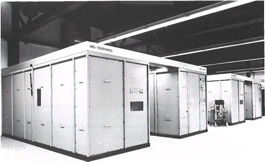
afb. 26 Zenderunit bij KG-zendstation Flevo. Het gehele blok (compleet met poort) vormt een PANTEL-zender met 500 kW vermogen. Tussen zender 1 en 2 een meetwagen.
